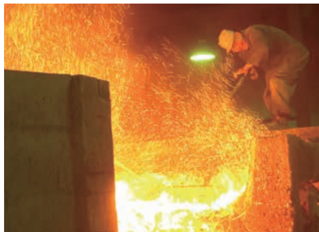
写真4 炉本体(釜)の破壊作業
